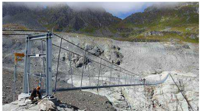
La passerelle de Panossière
